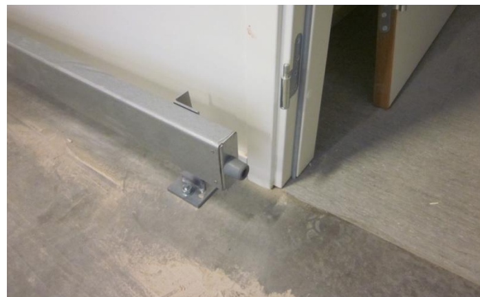
Avslut med nitad Ändplåt och monterad dörrstopp
